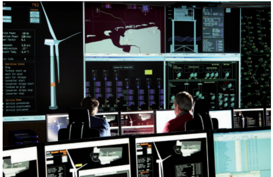
Die Bard-Leitzentrale beobachtet und regelt Offshore-Windparks.
