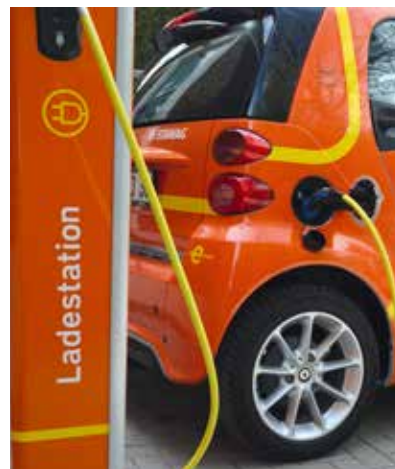
Ladesäule: Softwarebasierte Netzregler fangen Spitzen beim Ladestrom ab.
